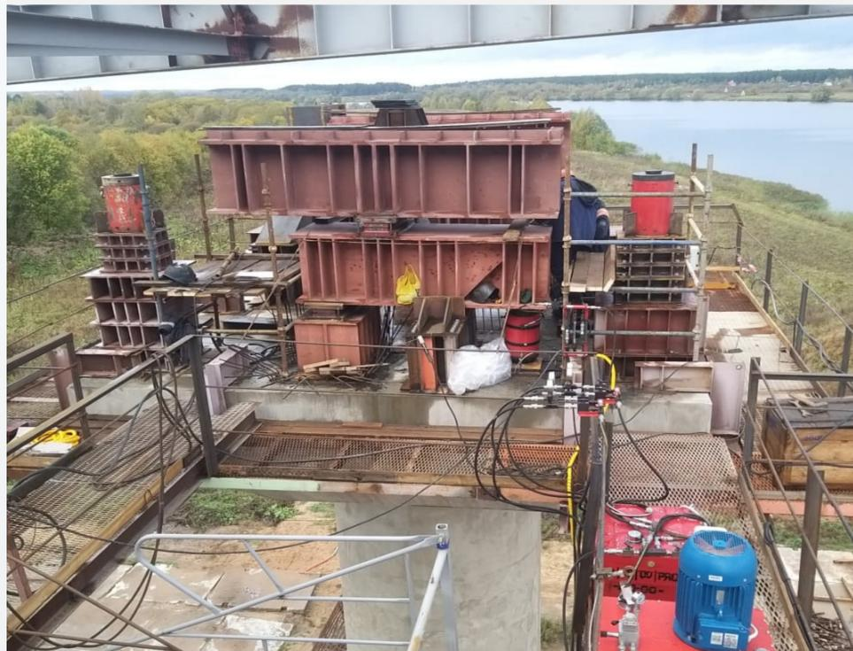
Балансирная система, воспринимающая вертикальную нагрузку и используемая для измерения реакций, позволяет:
