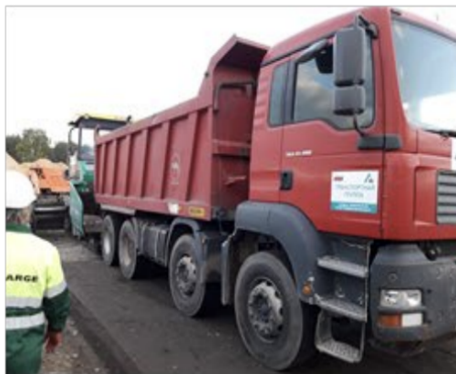
Доставка бетонной смеси на объект
