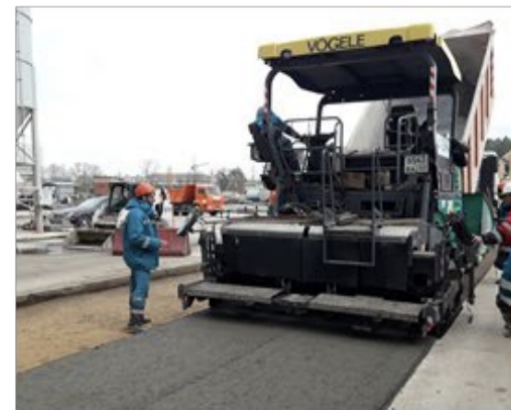
Укладка бетонной смеси асфальтоукладчиком
