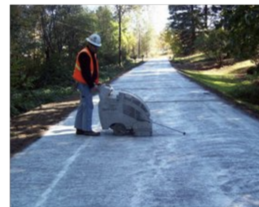
Нарезка деформационных швов
