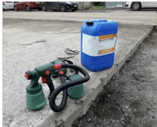
Нанесение защитного покрытия (кьюринг)
