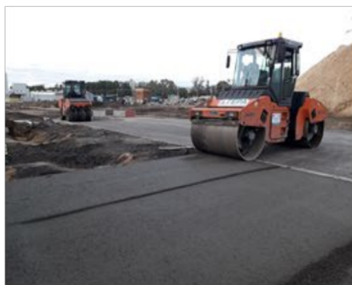
Уплотнение бетонной смеси катками
